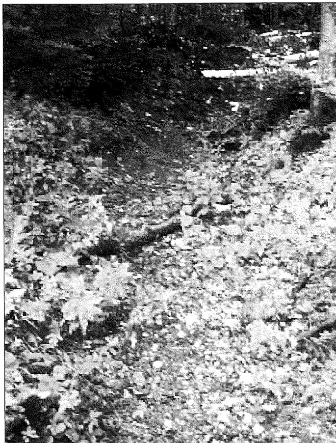
Foto 3 – Pista di strascico messa a riposo. Si noti la stanga posta di traverso al tracciato per l'intercettazione dell'acqua di scorrimento superficiale.
