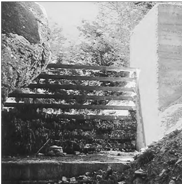
Figura 5 – Briglia filtrante realizzata nel 1966 nel Vallone dell'Inferno ad Anzi (PZ) e colmatasi nell'inverno successivo (foto PUGLISI).
