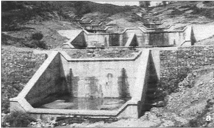
Tav. 4 – Batteria di briglie a bacino sul Torrente Gallitello nei pressi di Potenza, al termine dei lavori di costruzione (a) (foto Puglisi), e dopo circa vent'anni di esercizio (b). Particolarità dell'opera in primo piano sono le spalle in gabbioni, cioè deformabili e drenanti, per difendere il corpo centrale dalla spinta delle sponde franose.
