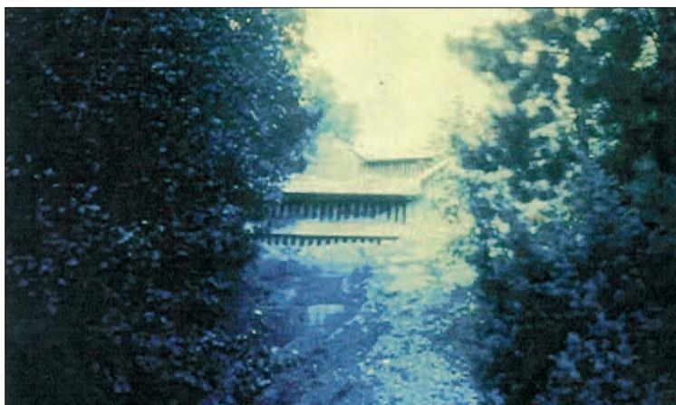
*Tav. 3* – Batteria di briglie sottili filtranti, in cemento armato, tirantate a monte, costruite in un canale di colata (Ravin de la Garguette) presso Grenoble, che stabilizzando l'alveo hanno avuto come effetto la formazione spontanea di un ontaneto sulle sponde (foto Puglisi).
