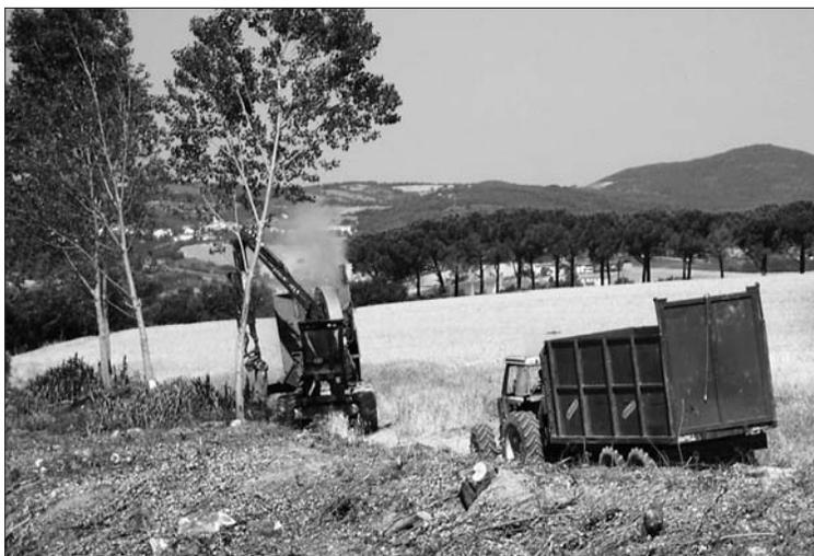
Figura 3 – Fiume «Fine», Santa Luce (PI). Cippatura della vegetazione ripariale lungo sponda.
