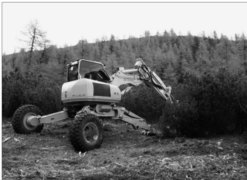
Figura 3 – Val Tedesca, Riserva Naturale Guidata Bosco della Scanupia: l'escavatore tipo «ragno» Batemag dotato di testata tipo trincia forestale Seppi in azione.
